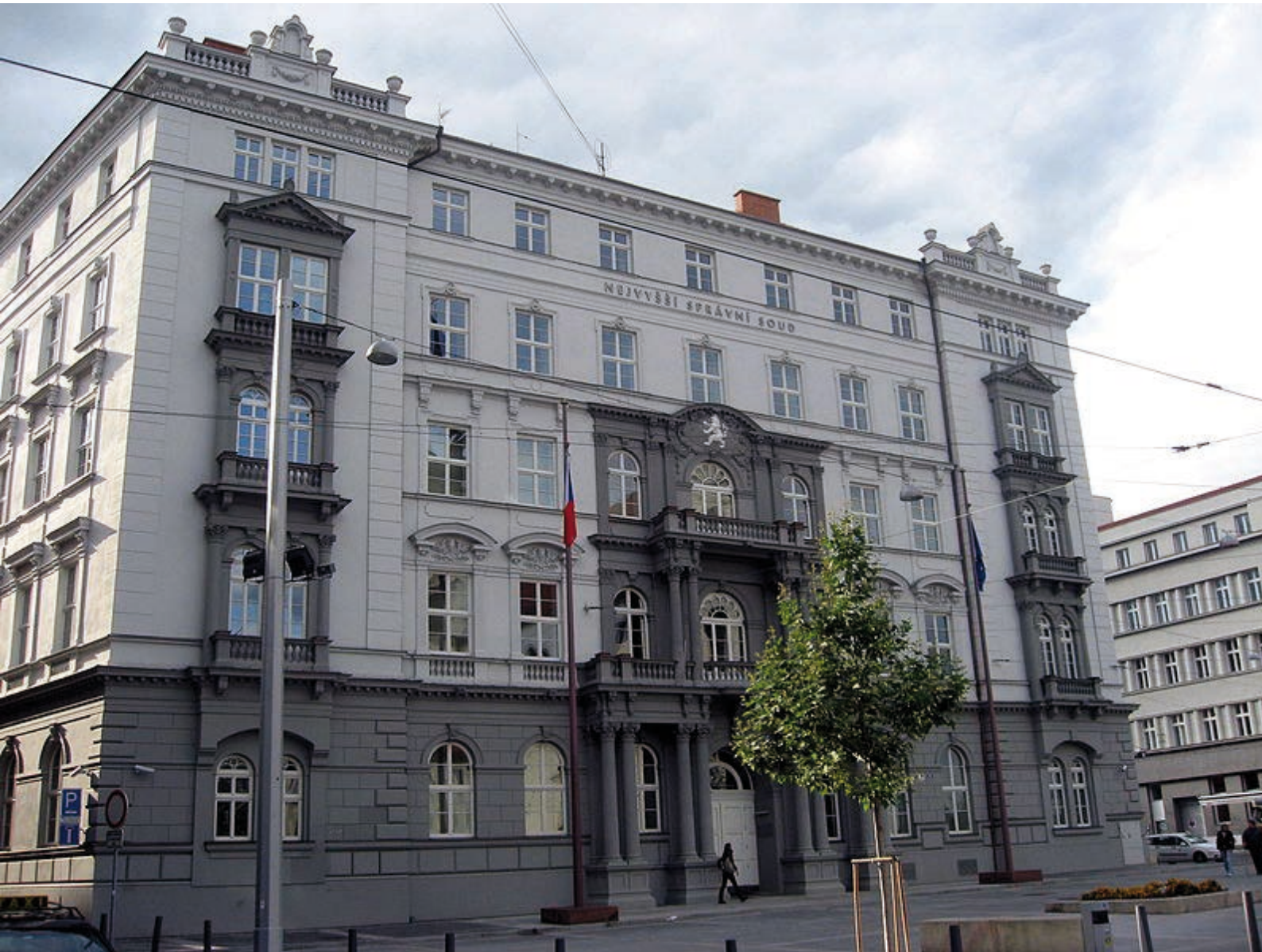
Budova Nejvyššího správního soudu v Brně [2]
