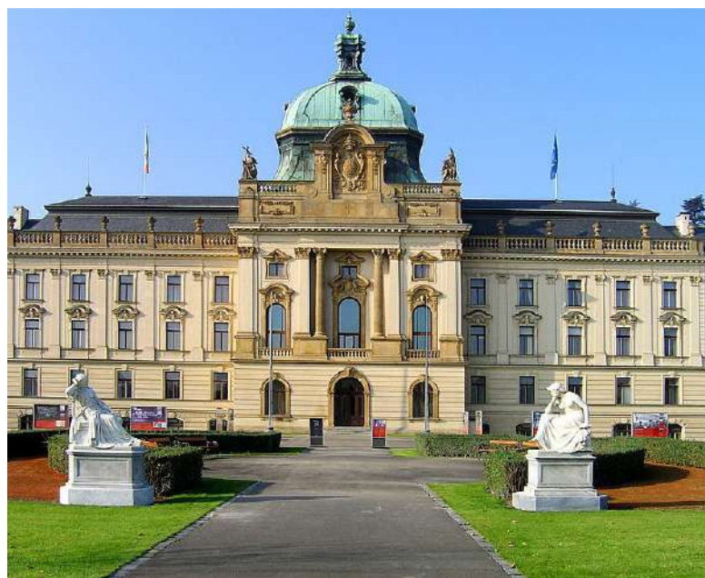
Budova Úřadu vlády ČR [2]
