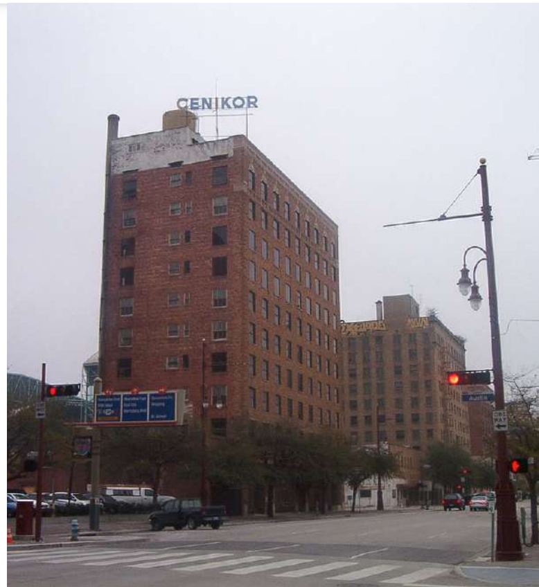
Budova spoločnosti Cenikor [2]
